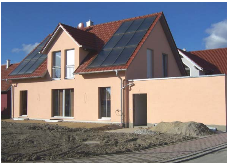
Die Kollektoranlage besteht aus zwei Feldern mit je 18 m 2 , beiseitig der Gaube angeordnet. Die Dachneigung beträgt ca. 50°
