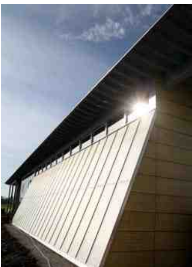
Kollektorfassade und Solarspeicher des Sonnenzentrums in Rottenburg.
