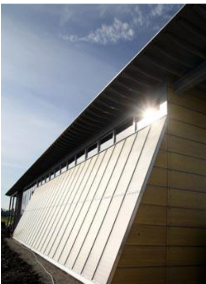
Kollektorfassade und Solarspeicher des Sonnenzentrums in Rottenburg.
