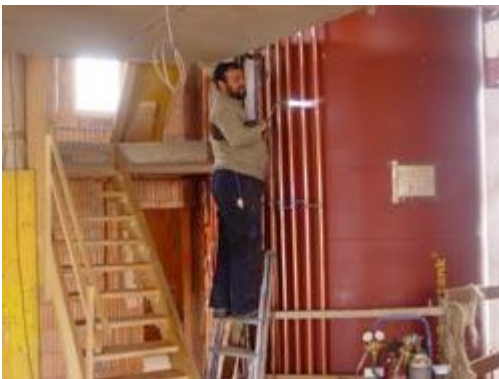
Verrohrung des Pufferspeichers (links); Speicher.
