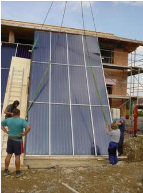
Montage der Fassadenkollektoren und des Solar-Speichers.
