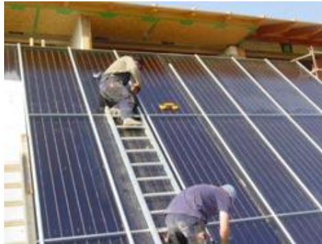
Photovoltaik-Module auf dem Dach (links) und solarthermische Kollektoren an der Schrägfassade
