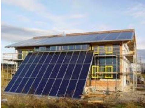
Photovoltaik-Module auf dem Dach (links) und solarthermische Kollektoren an der Schrägfassade
