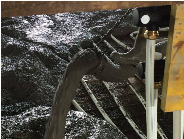
Durch Betonkernaktivierung wird der Hallenboden zum Wärmespeicher. Foto: SST Solar
