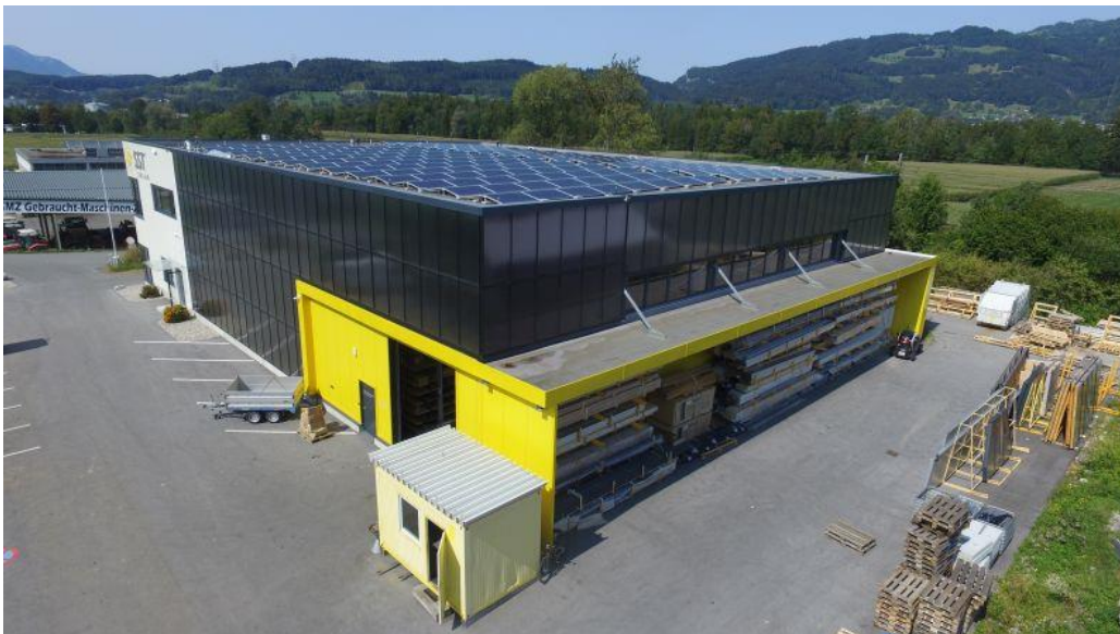
An den Fassaden erzeugen Solarkollektoren, auf dem Dach Solarstrommodule umweltfreundlich Energie. Foto: SST Solar
