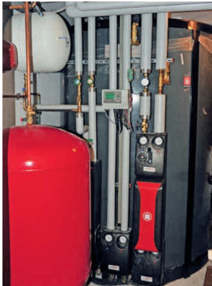
Mit dem 4.000 l fassenden Schichtenspeicher von ratiotherm werden längere Kälteperioden überbrückt.
