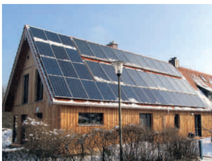
Mit dem Anbau kamen 95 m 2 Wohnfläche hinzu, der Gesamtenergiebedarf reduzierte sich jedoch um rund 90 Prozent.
