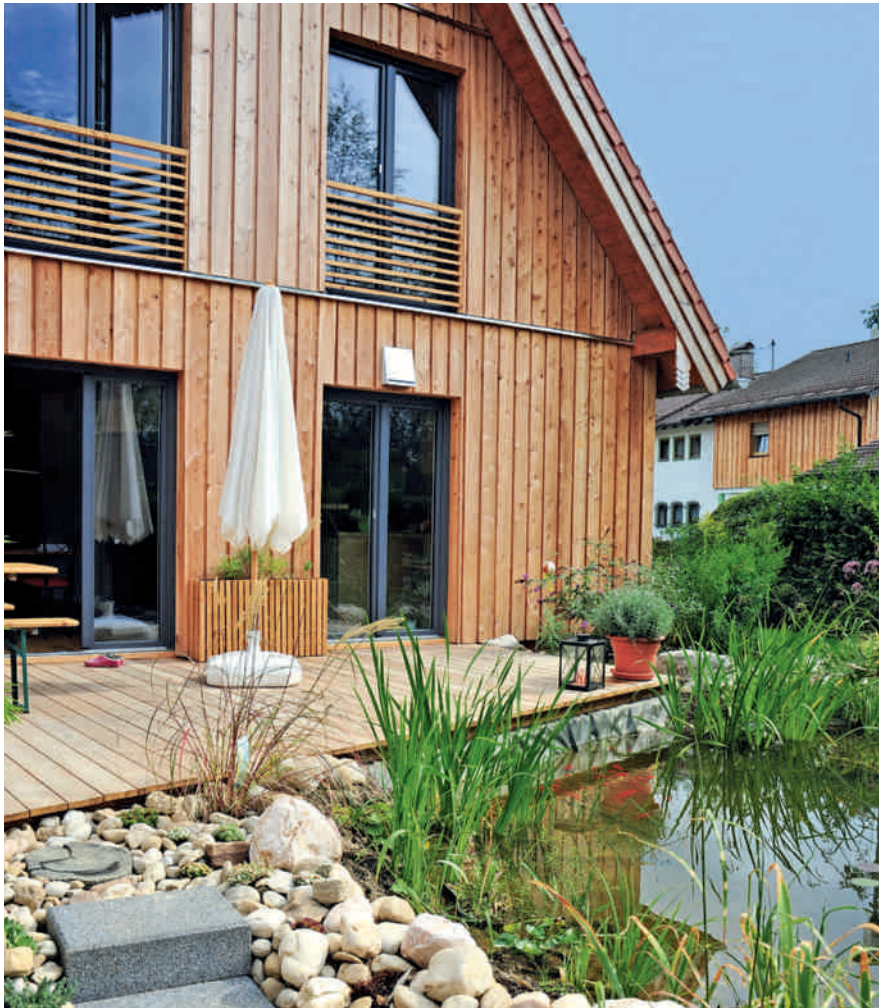
Abgerundet wurde die aufwendige Komplettsanierung und Wohnraumerweiterung mit einem neu gestalteten Terrassen- und Gartenbereich mitsamt Fischteich.
