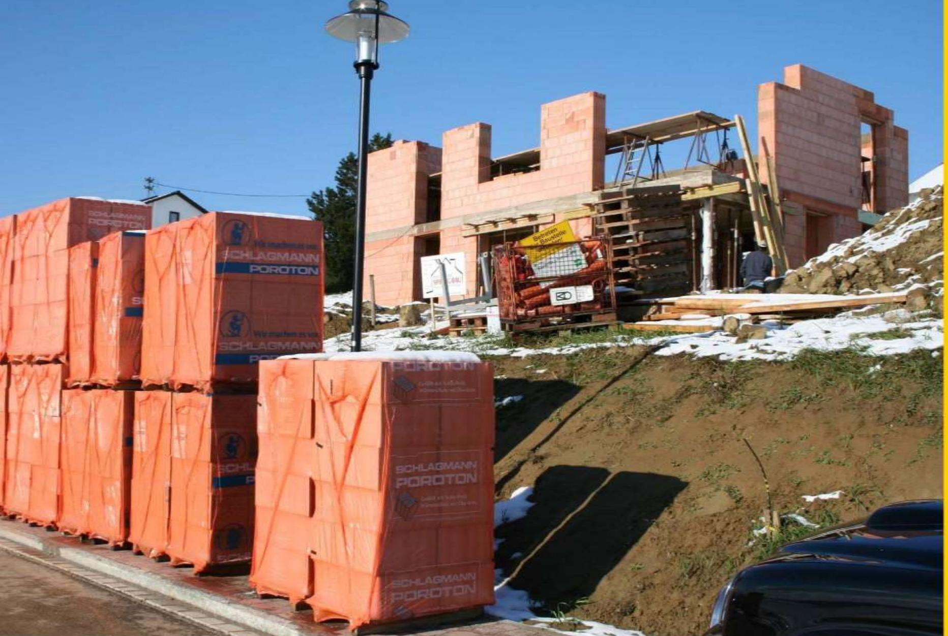
Ziegelmauerwerk U-Wert ca.  $0,18 \text{ W/m}^2\text{K}$
