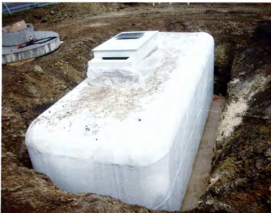
Die liegenden Speicher von Ebitsch werden aus glasfaserverstärktem Kunststoff (GFK) gefertigt.
