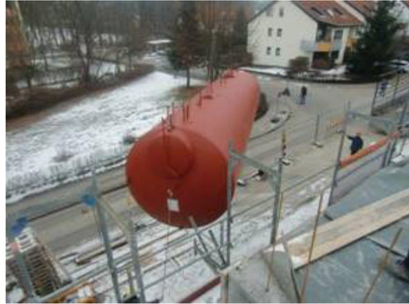
*Am 31. Januar 2011 wurde der Pufferspeicher mit seinen 47.100 Litern Fassungsvermögen in den Rohbau eingesetzt. Die Anlieferung war auch hier Präzisionsarbeit.*
