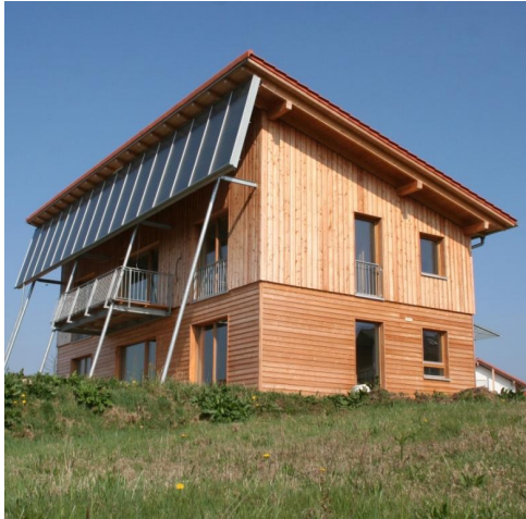
Große Süd-Fenster und die steil geneigte Solarfläche fangen im Winter viel Sonne ein.
