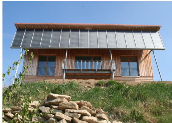
Große Süd-Fenster und die steil geneigte Solarfläche fangen im Winter viel Sonne ein.
