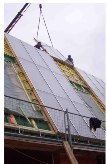
Speichereinbringung, Installation, Kranmontage Solardach
