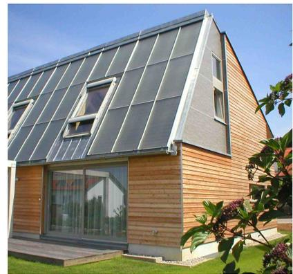
Massivbau mit Thermohaut und Holzverkleidung, das 60° geneigte Süddach ist komplett mit Kollektoren bestückt
