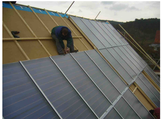
Einbringung des fertig verrohrten Großspeichers und Kranmontage der Kollektor-Großflächenmodule
