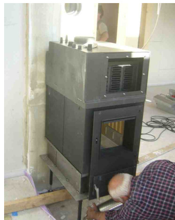
Montage des modular aufgebauten Grundofeneinsatzes
