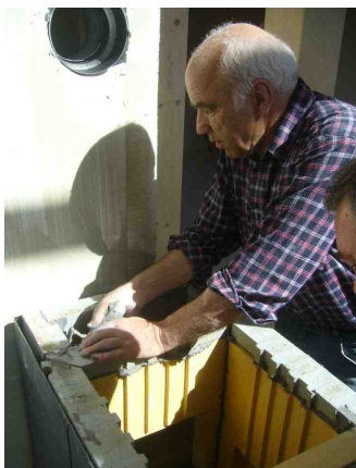
Montage des modular aufgebauten Grundofeneinsatzes
