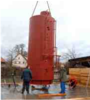
Einbringung des fertig verrohrten Großspeichers und Kranmontage der Kollektor-Großflächenmodule
