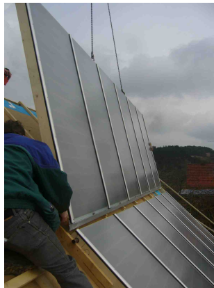
Einbringung des fertig verrohrten Großspeichers und Kranmontage der Kollektor-Großflächenmodule
