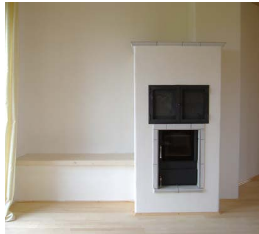
Außen Kachelofen, innen Holzvergasertechnik: Der POWALL- Zentralheizungssofen reicht als einzige Nachheizquelle.
