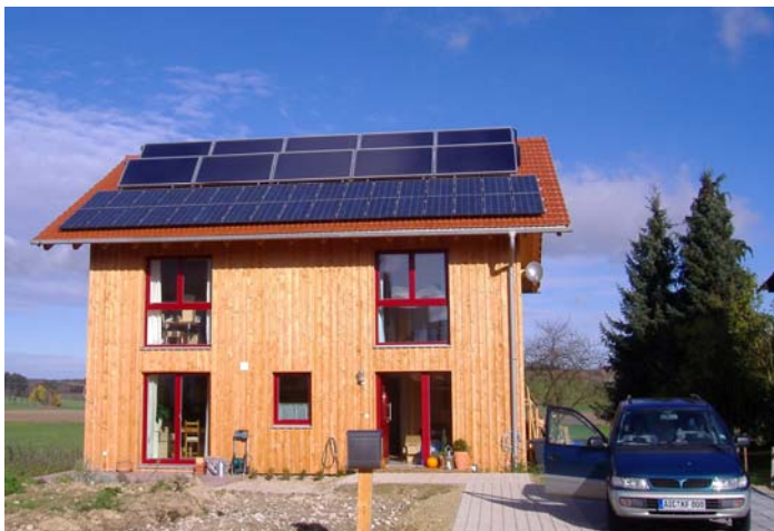
Die Kollektormodule oberhalb der Solarstromanlage wurden zur besseren Ausnutzung auf 50° aufgeständert.
