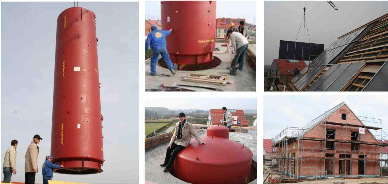
Am 20.10.2005 wurde der 40-Kubikmeter-Solarspeicher eingesetzt und per Autokran auf den Zentimeter genau positioniert. Ebenfalls per Kran montierte die Fa. Soleg aus Zwiesel die anschlussfertig gelieferten Kollektormodule.
