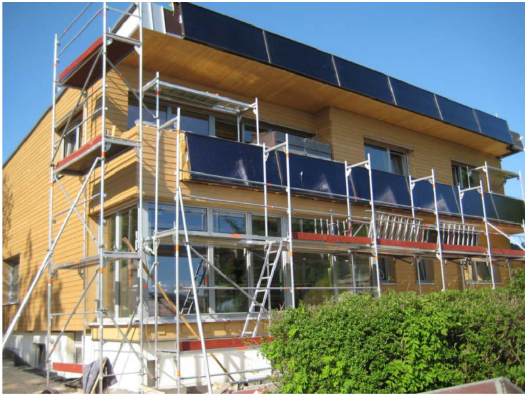
Das „Sonnenhaus“ in Göppingen-Hohenstaufen: 45 m 2 Kollektorfläche am Haus und auf dem Garagendach decken rund 80 Prozent des Energiebedarfs.
