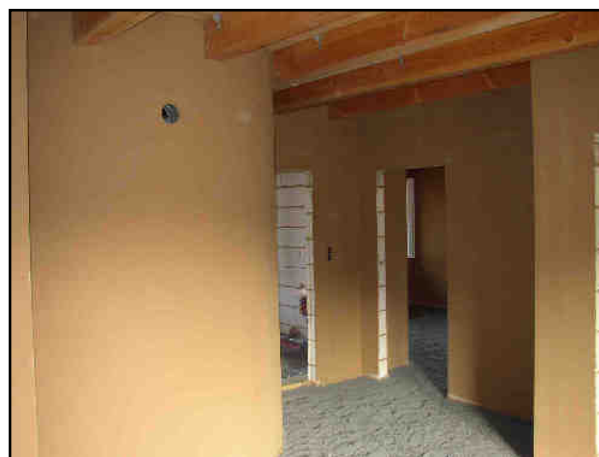
Lehmputz vor dem Anstrich
