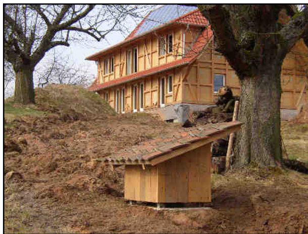
Von der Frischluftfilterbox im Garten geht es 45m durch die Erde ...
