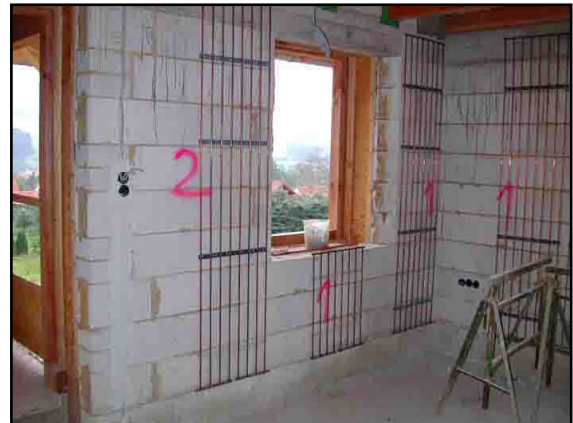
Wandheizregister vor dem Verputzen
