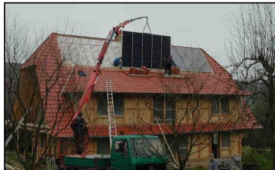
Eines von drei Kollektorfeldern á 15m² wird aufs Dach gehoben
