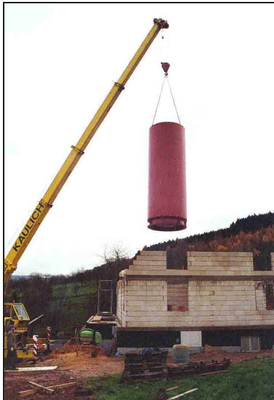
Der 5½m hohe Speicher wird während der Rohbauphase ins Haus gehoben...
