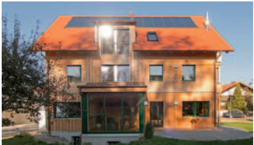
36 Quadratmeter Kollektorfläche decken in dem Vierfamilienhaus 50 Prozent des Jahresheizwärmebedarfs mit Sonnenwärme
