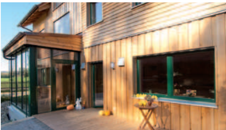
Kiefern- und Douglasienbretter für die Außenverkleidung des 4-Familienhauses stammen aus dem eignen Wald der Bauherren
