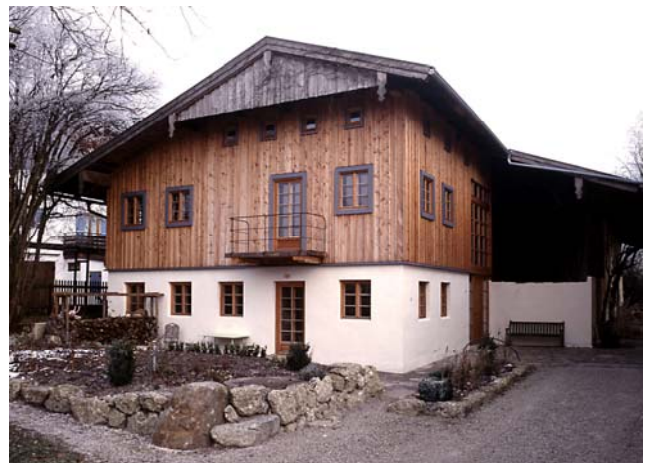
Die Naturstein-Außenwände im EG wurden erhalten und neu verputzt. Die Temperierung mit einer Wandflächenheizung sorgt für behagliches Klima.
