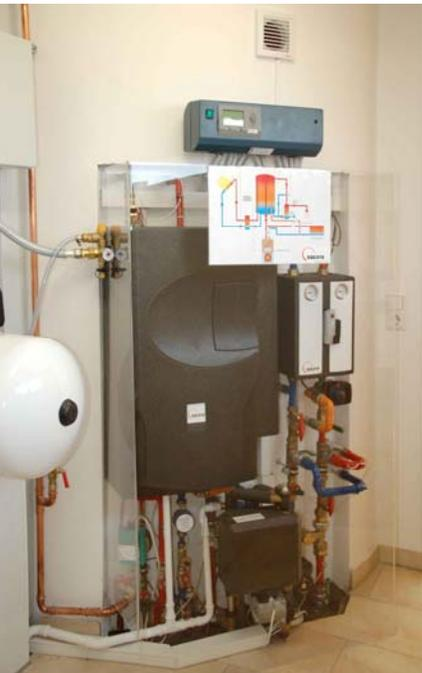
Erste Erfahrungen aus dem Musterhaus im Dezember 2007 haben gezeigt, dass auch bei winterlich kalter Witterung die gespeicherte Wärme im Pufferspeicher ca. eine Woche ausreicht, bevor mit dem Ofen wieder Wärme zugefügt werden muss.
