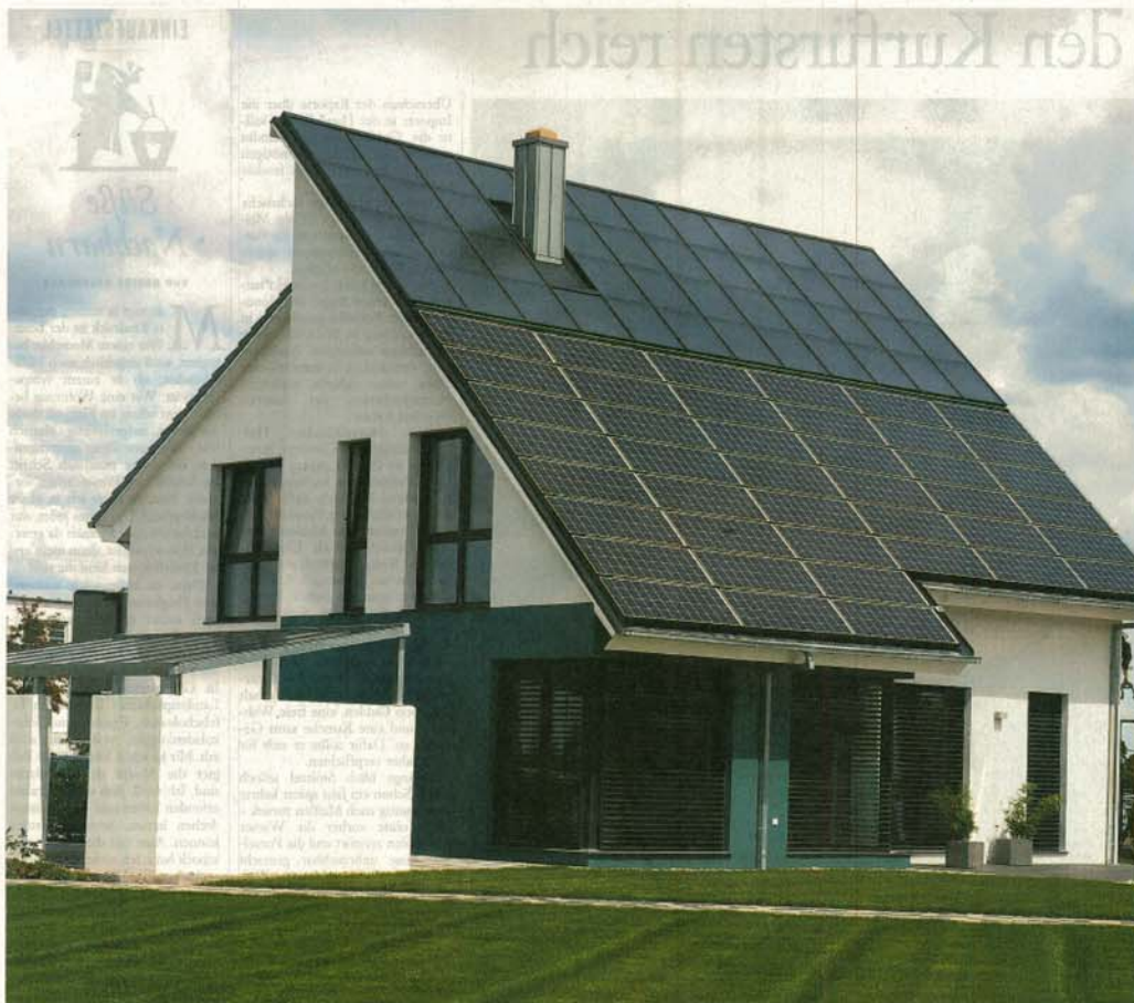
Das energieautarke Haus in Lehrte hat die Dachfläche mit den Sonnenkollektoren und den Photovoltaikzellen nach Süden ausgerichtet. So muss es auch sein für eine optimale Sonnenstrahlenergie. Die Kollektoren in der oberen Hälfte des Daches sammeln die Sonnenwärme, die indirekt die Räume erwärmt. Die Photovoltaikanlage, die den unteren Teil der Dachfläche belegt, wandelt Licht in Strom, sogar mehr als genug. Überschüssiger Strom wird im Blei-Akku (oben) gespeichert und speist das häusliche Stromnetz, wenn es dunkel wird. Der Strom reicht auch noch, um einem Elektrofahrzeug, hier Roller, die nötige Energie zu liefern.
