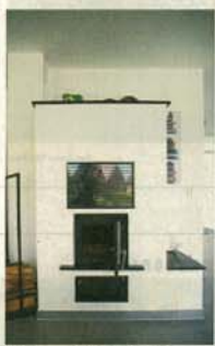
Wenn es im Winter kalt wird, kommt dieses Gerät ins Spiel. Es sieht aus wie ein Kamin, ist aber ein Holzvergaser für rund 2000 Euro, der die Brandstätte in den Warmwassertank lenkt.
