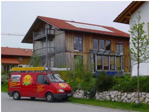
Der 32 m 2 Hochleistungsflächenkollektor deckt den Heizenergiebedarf etwa zur Hälfte ab. Große Glasflächen auf der Südseite bringen zusätzlich passive Wärmegewinne.
