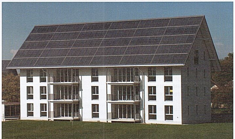
Bild 9 Baujahr 2007: Mehrfamilienhaus in der Schweiz von Jenni-Energietechnik mit acht Wohneinheiten und einem Primärenergiebedarf von 4 kWh/m²a. Es beheizt sich mittels Solarthermie und Langzeitwärmespeicherung ganzjährig zur 100 % nur mit der Sonne. Auf eine Heizkostenabrechnung wird verzichtet. Es gibt Wartelisten für die Vermietung. (Quelle: Sonnenhaus-Institut e. V.)
