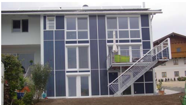
Die neu gestaltete Südfassade: In die Holz-Glas-Fassade wurden 23 m 2 Kollektor integriert. Auf dem Dach wurden ca. 21 m 2 Modulkollektoren aufgeständert und eine 4,55 kW PV-Anlage montiert.
