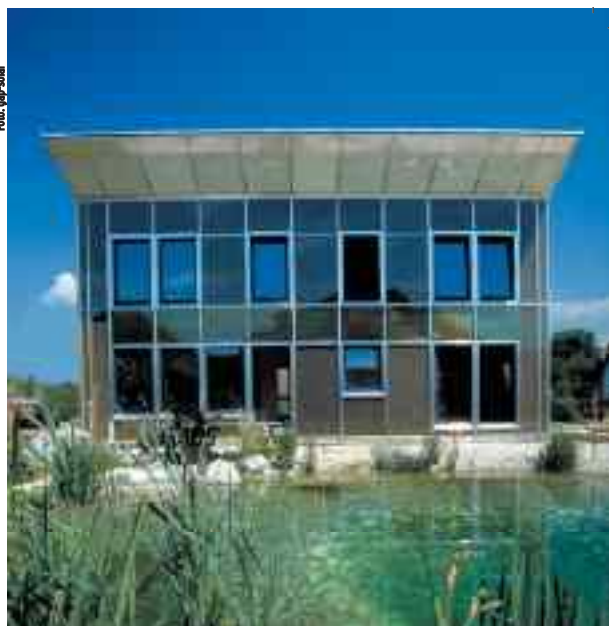
Das Passivhaus Pree (oben) steht in Linz. Wände und Unterseite des Pultdaches sind komplett verglast. Gefärbte Solarwaben und eine 40 Millimeter dicke Dämmung sorgen für Temperaturengleich. Die Wabe sorgt dafür, dass die hoch stehende Sommersonne reflektiert wird, die flache Wintersonne dagegen passieren kann. So soll eine warme Hülle entstehen. Das Sonnenhaus von Familie Lorenz (unten) steht in Kumhausen, Bayern. Im Zentrum steht ein großer Solarspeicher. An den wenigen Tagen des Jahres, an denen die Solarwärmeanlage nicht ausreicht, heizt ein Kachelofen nach. Der Brennstoffbedarf liegt bei 1,5 Raummetern Holz pro Jahr.
