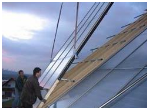
Kran-Montage der Großflächenkollektoren.
