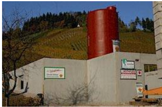
Sonnenkollektoren auf dem Süddach und am Terrassengeländer; 42.000 Liter-Solarspeicher.
