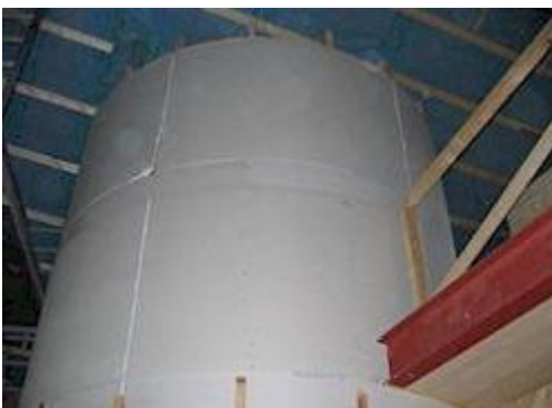
Links: Gedämmter Solarspeicher. Rechts: Der Speicher enthält auch zwei Boiler für das Trink- und Regenwasser.
