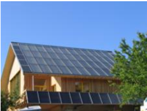
Sonnenkollektoren auf dem Süddach und am Terrassengeländer; 42.000 Liter-Solarspeicher.
