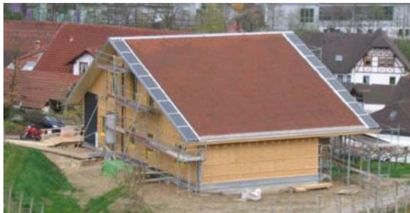
100%-Solarhaus in Kappelrodeck (Nordseite).
