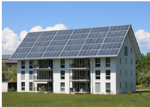
Das ausgezeichnete Projekt: erstes 100% solar beheiztes Mehrfamilienhaus Europas in Oberburg BE
